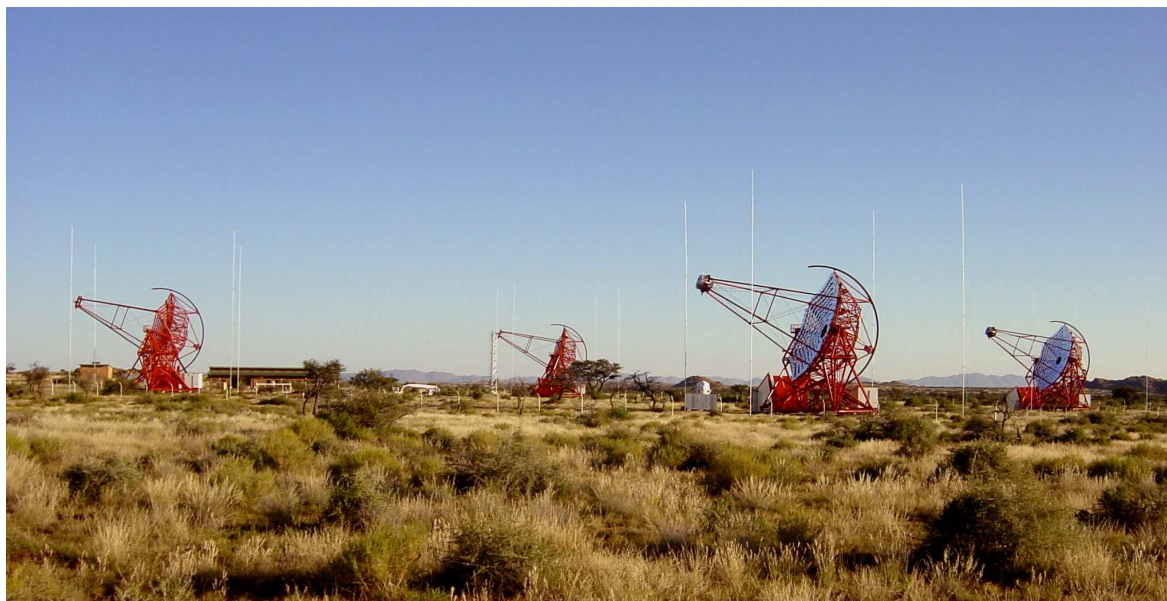
Abbildung 8.1: Die vier ersten H·E·S·S-Teleskope in Namibia. Die ersten beiden Teleskope (links) sind bereits vollständig ausgestattet und in Betrieb (Stand April 2003). Quelle: http://www.mpi-hd.mpg.de/hfm/HESS/HESS.html/public/chronology.html .
